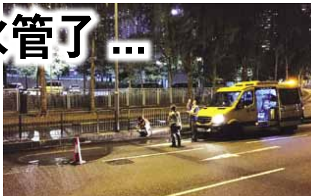
維修工程進行中。
