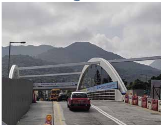
西貢公路第一期改善工程已如火如荼。
