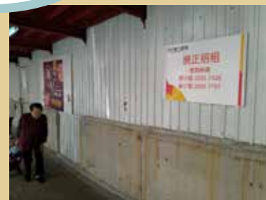
商場興建下行扶手電梯，料最快下月完工。
