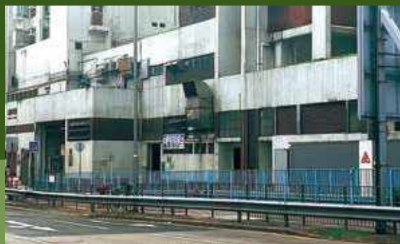
大圍街市關閉 7 個月進行加裝冷氣工程。
