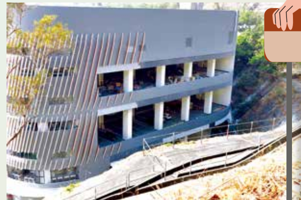
三層高驗車大樓，每日可檢驗過千車輛。
