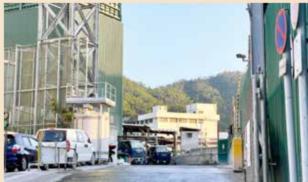
驗車大樓附近有混凝土廠。
