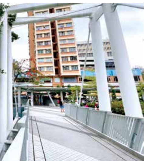
公園新建行人吊橋，延續荃灣天橋城市的暢通網絡。
