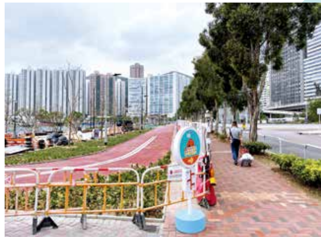
荃灣西站海旁新單車徑上月底啓用。
