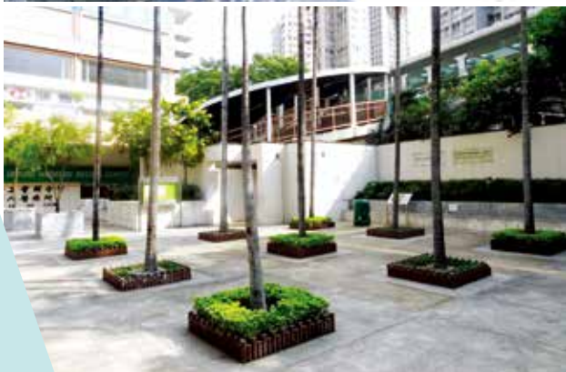
重建前的花園缺乏對外直接通道。
