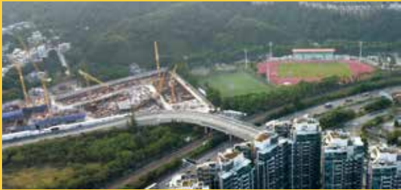
擬建白石角站用地 旁正興建私人住宅 項目。
