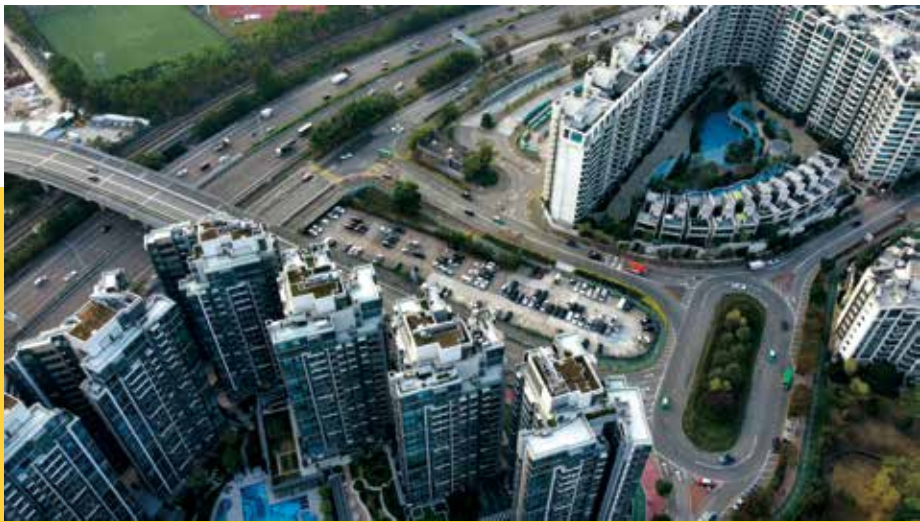
白石角車位不足，屋苑外只有科城路臨時停車場。
