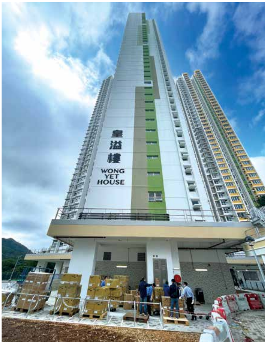
政府日前宣佈徵用皇后山邨皇溢樓及皇澄樓，作隔離中心用。
