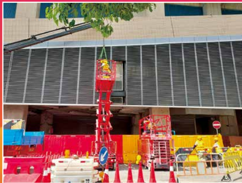
港鐵上月派出工作人員改善排氣口問題，並將排氣板反轉，熱氣向上排放。
