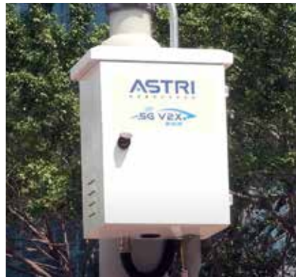
為實地測試車聯網技術，沙田指定路面已裝設測試設備。
