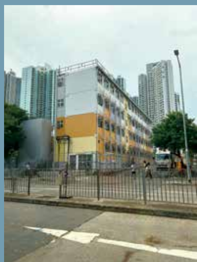
「簡約公屋」與過渡屋一樣採組裝合成法興建。（資料圖片）
