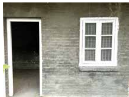
車站當年的木門及木窗框，仍原封不動。
