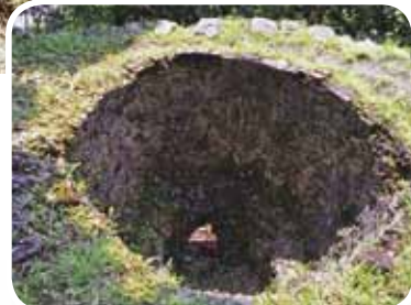
灰窰呈圓筒形，內環以磚塊砌成，而外部再以石塊加固。
