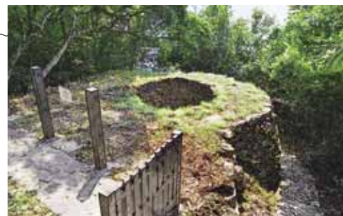
灰窰呈圓筒形，內環以磚塊砌成，而外部再以石塊加固。
