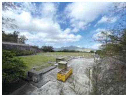
丹桂村配水庫為元朗及天水圍供應食水。
