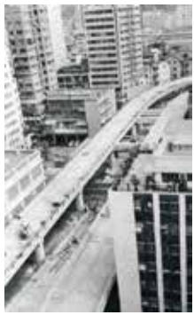
告士打道天橋興建時，無阻消防局運作。
