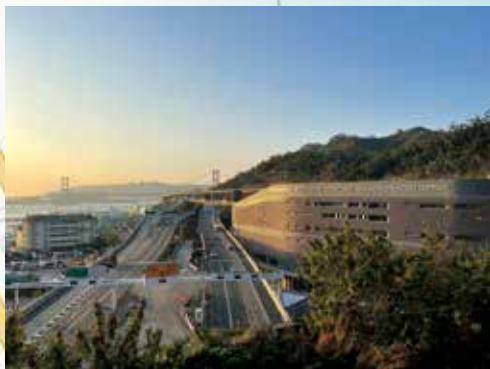
青衣運署驗車大樓於2021年3月啓用。
