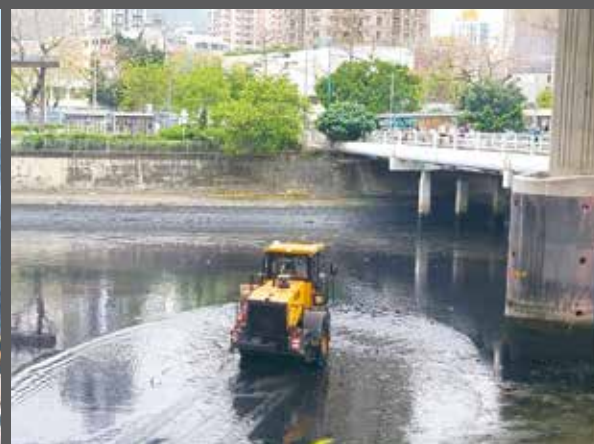
渠務署為屯門河清除淤泥。
