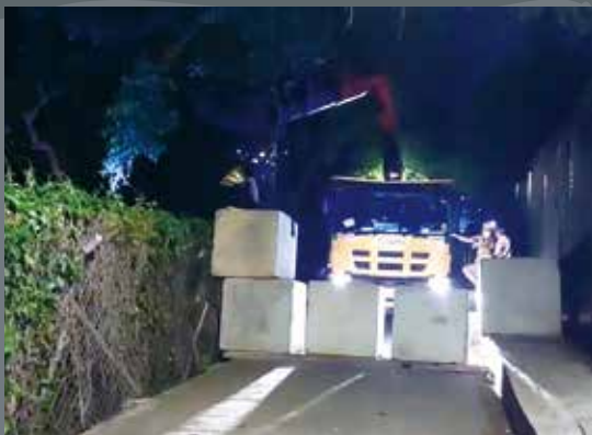
深夜時份，吊車將石躉移除。
