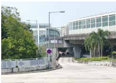
08年青沙公路通車，已留四接駁口供T4用。
