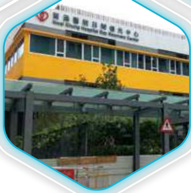
早前首期重建的日間大樓已投入運作。
