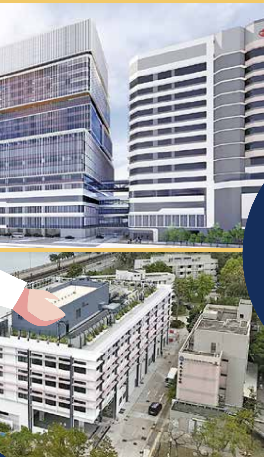
沙田醫院建調遷大樓助威院重建，項目 2020 年建成。
