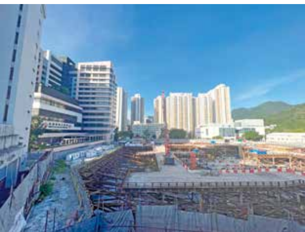
現時舊宿舍已拆，騰出建新翼大樓空間。
