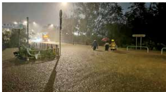
沙頭角公路水浸，消防協助被困居民離開。
