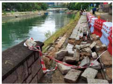
林村河石牆被破壞，河堤出現缺口。
