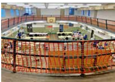
該會所現仍用作庇護工場，上層的鑲形跑道已停用。
