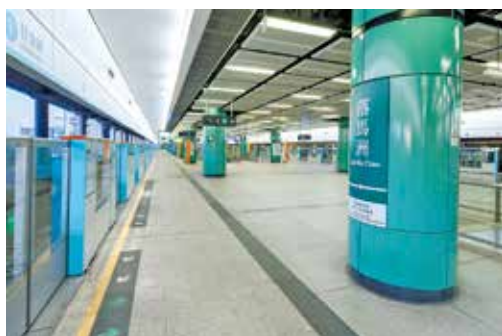
落馬洲站閘門月中完成安裝並啟用。
