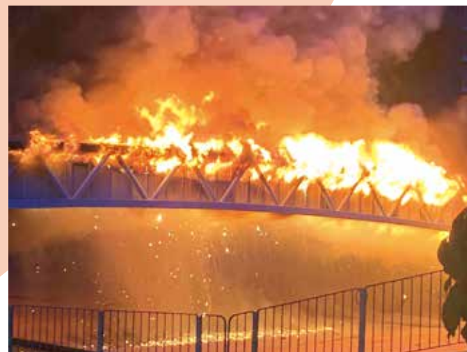
前年 6 月，元朗朗屏中電電纜橋起火燒毀。
