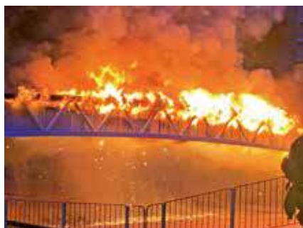
元朗電纜橋 2022 大火，未有觸發懲罰機制。
