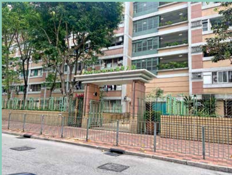
滿樂大廈四座樓宇中，安寧樓參與垃圾徵費先行先試。
