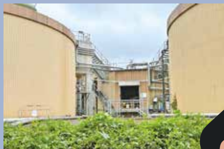
渠務署證實污水廠有喉管淤塞而導致事故。
