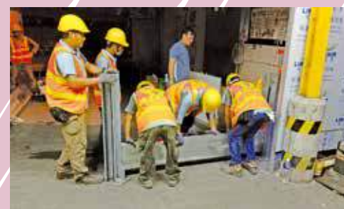
南圍響鐘等多處村屋，安裝可拆擋板。
