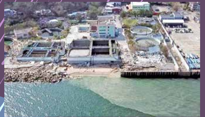
西貢污水處理廠曾遭超強颱風破壞。
