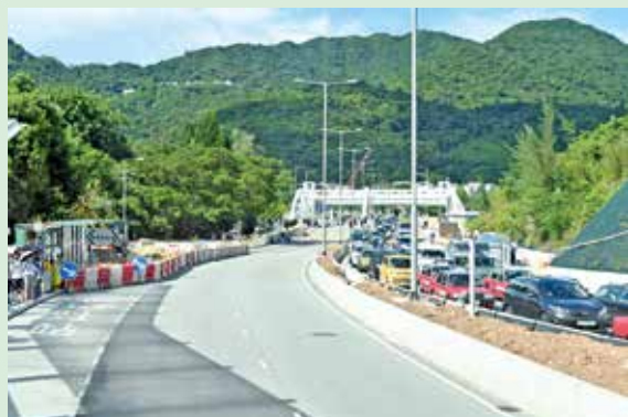
西貢公路改善工程第一期 2021 年完成。
