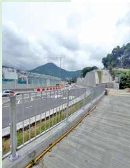
改善工程第一期有加設隔音屏障。
