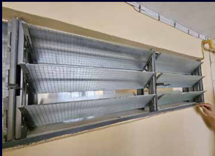
房署明年起為部分屋邨，分階段圍封走廊通風窗。
