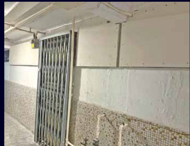
原有的通風扇窗將免費更換成防火板。
