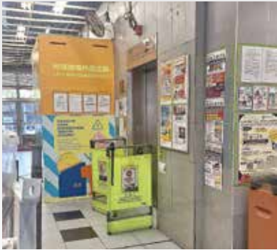
大窩口邨富德樓高層電梯一度運作全停。
