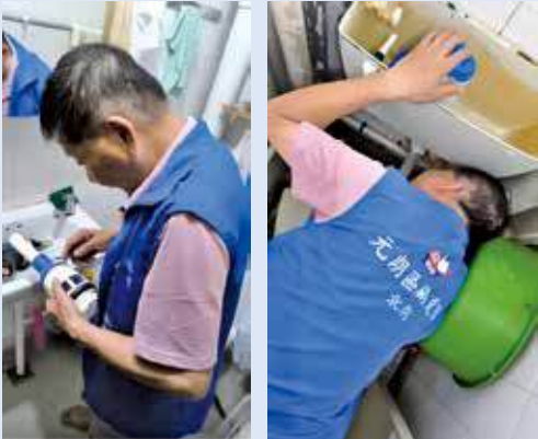
義工亦為長者住戶維修廁所水箱。
