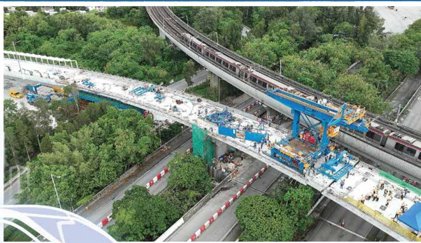
繼去年10月落馬洲港鐵站附近通往河套地區香港園區的西面連接道路開通，今年6月河套區發展項目的行車橋結構亦全部完成。當中有連接路，由全球首應用的全跨度橋樑吊裝技術所建造，大幅減少九成因工程的封路次數。土拓署下一步計劃在河套區東面增建道路連接古洞北新發展區。地區人士期望可規劃河套區成無人駕駛試點地區，推進該處科技發展。
