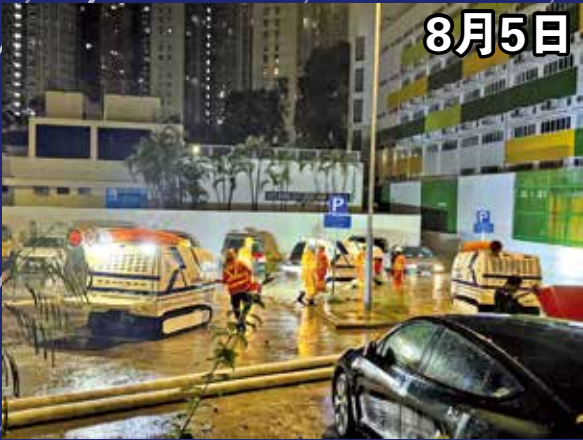
8月5日三架排水機械人「龍吸水」於敬賢里停車場全力協助，務求盡快清理水浸。
