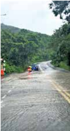
西沙路落大雨時出現水浸，車輛去路被阻。
