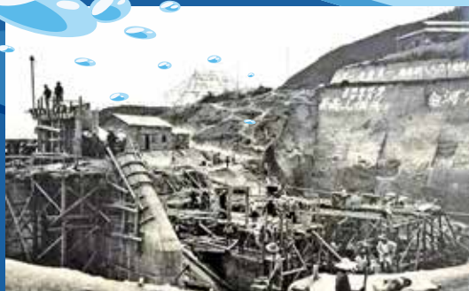
國家僅用一年多，就完成東深供水工程。（歷史圖片）
