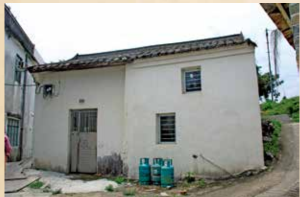
烏蛟騰交通站舊址，是村內現仍保留的一間舊屋。
