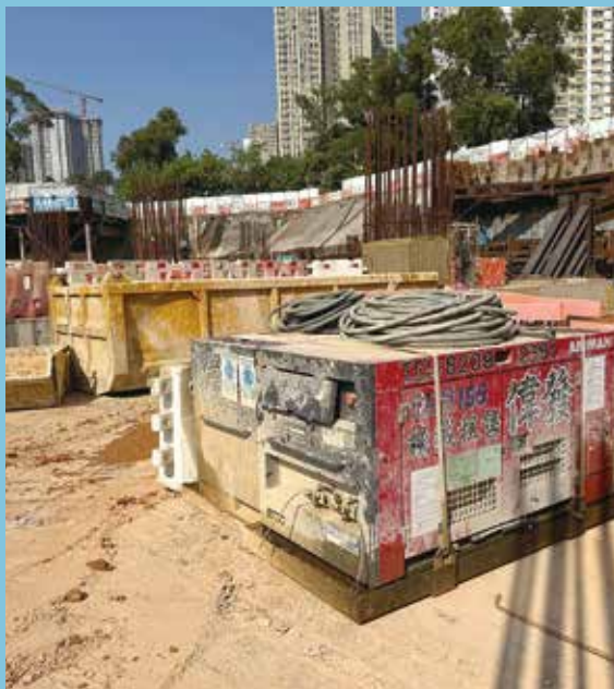
大樓進行地底樓層工程。
