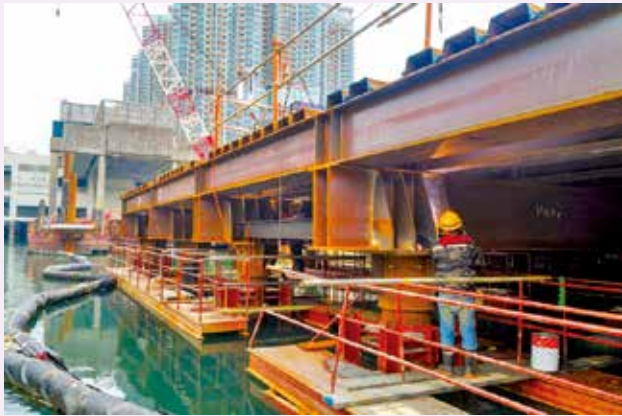
屯門河上建高架橋，接駁屯門南延線站。
