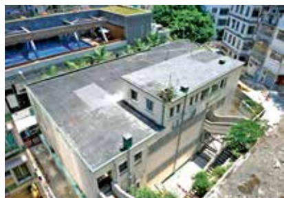
建築樓高三層，頂層空間狹小。
