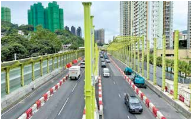
大埔公路沙田段改善工程於去年底完工。
