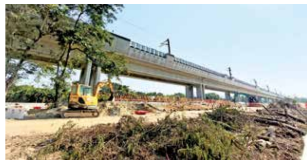
洪水橋正興建屯馬線分站，未來將成跨境鐵路轉車站。
