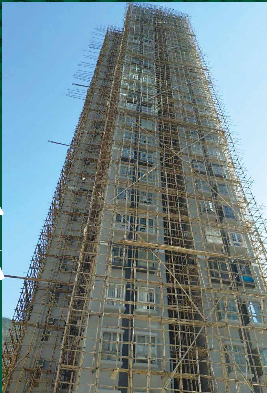
葵涌怡勝花園樓宇搭起棚架圍網多時。
