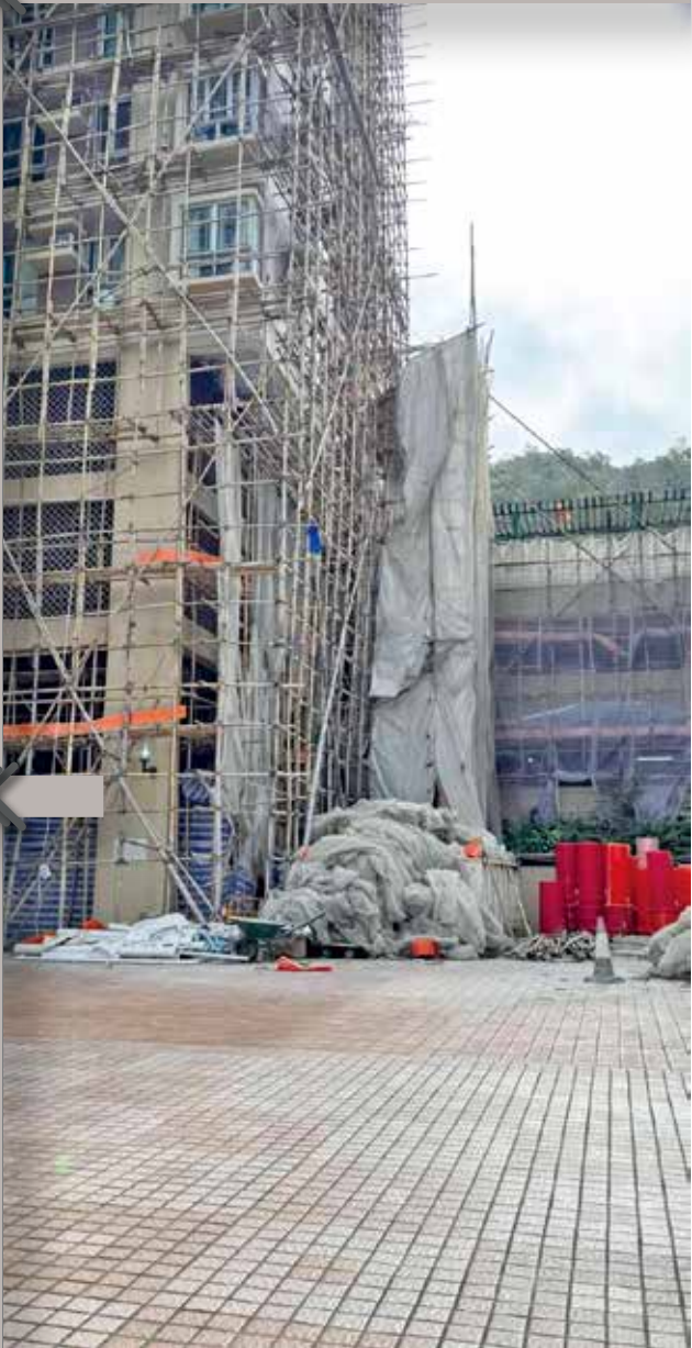
屯門怡樂花園樓宇搭起棚架圍網多時。
