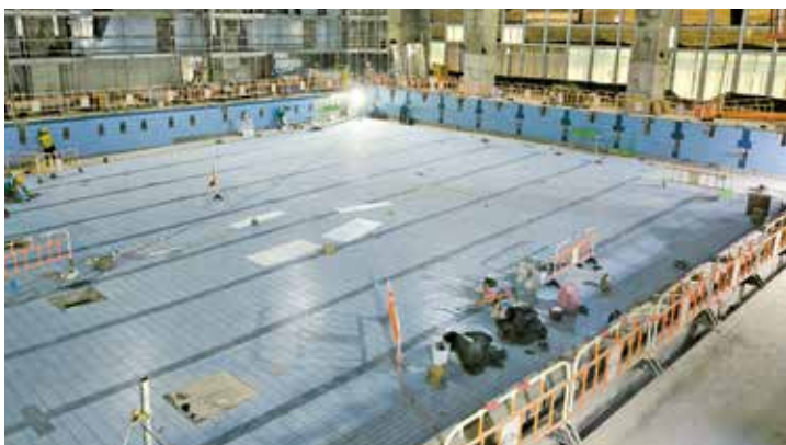
新泳池內部正進行裝修和設備安裝。
