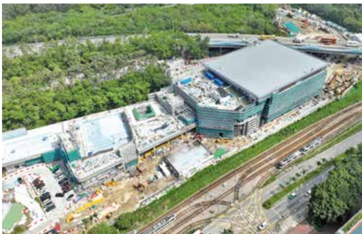
新泳池興建位於龍門路，已接近完成。
