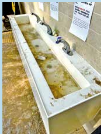
營地附近的洗手盆，疑被食物殘渣及泥沙堵塞。
