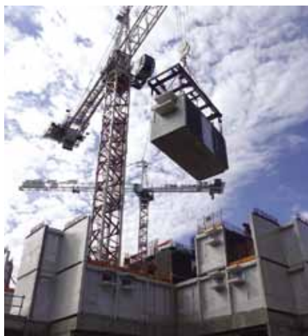
工程人員示範把一個預製組件吊起，嵌入已設定的位置。
