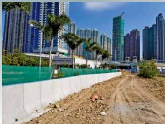
將軍澳南正興建擋水牆，圖為山竹後興建的擋水牆。
