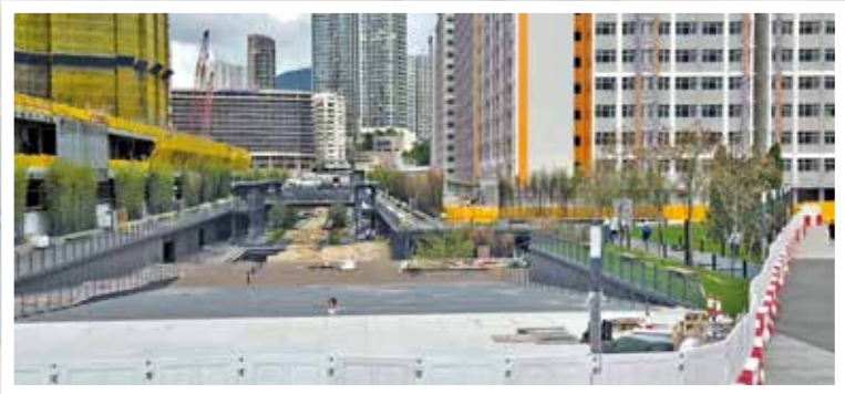
龍津石橋保育長廊工程正在進行。
